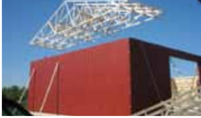
4. Sen jälkeen nosturiautolla nostetaan ristikot paikoilleen
