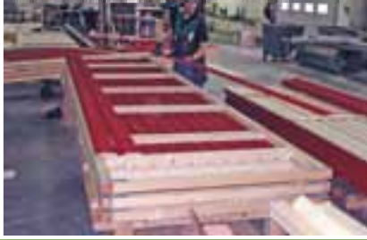
1. Pienelementtien valmistus tehtaalla
