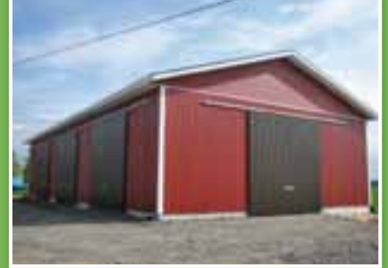
5. Viimeiseksi asennetaan aluskate, kattopellit ja räystäslaudat sekä ovet ja ikkunat
