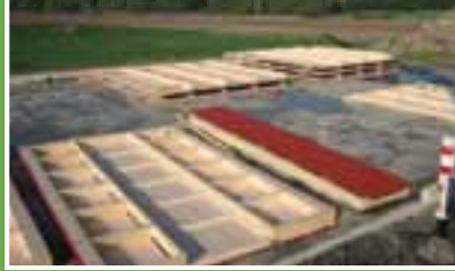
2. Pienelementtien Asennus alkamassa valmiiden perustusten päälle
