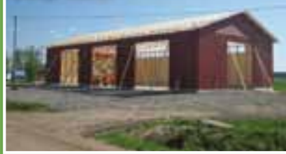
5. Viimeiseksi asennetaan aluskate, kattopellit ja räystäslaudat sekä ovet ja ikkunat
